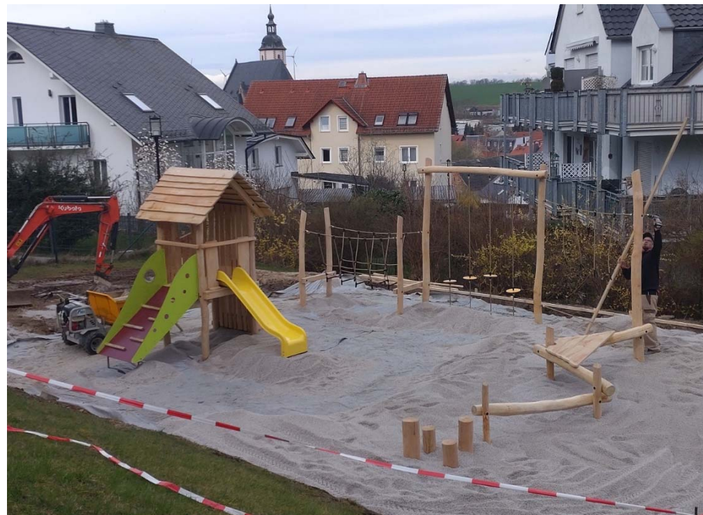
Spielplatz unterhalb Feldstraße 3, im Bau 03/2023
